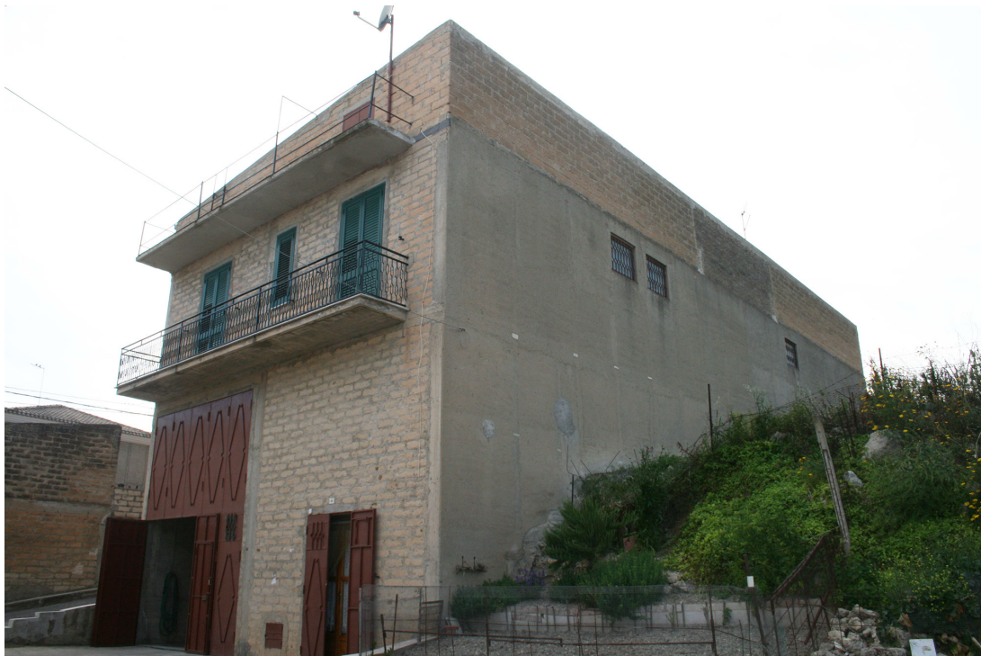
Außenansicht des Wohnhauses in Ravanusa
